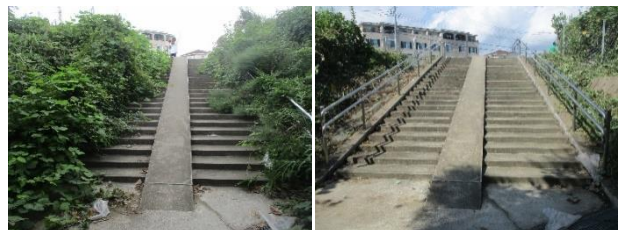
常磐道トンネル(谷和原 36)の歩道の“ビフォーアフター”
